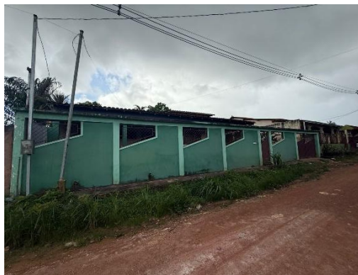
Figura 17: Muro da Fachada
