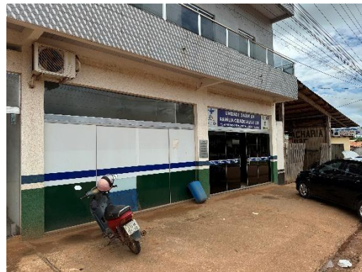
Figura 3: Fachada do imóvel
