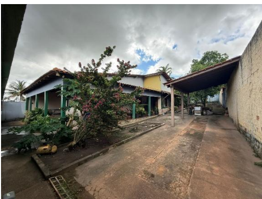
Figura 16: Fachada frontal e lateral
