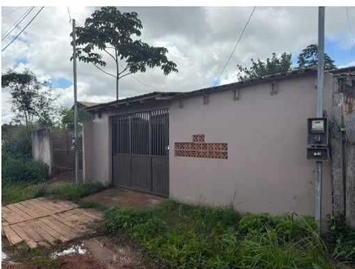
Figura 18: Muro da Fachada
