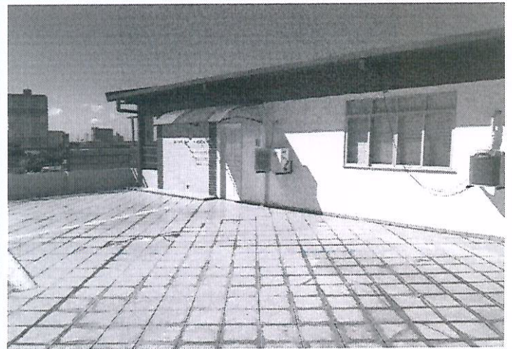
Área externa da cobertura
