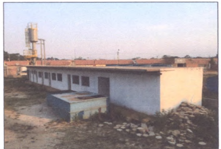
Foto 04 - Casa de química, laboratório e escritório
