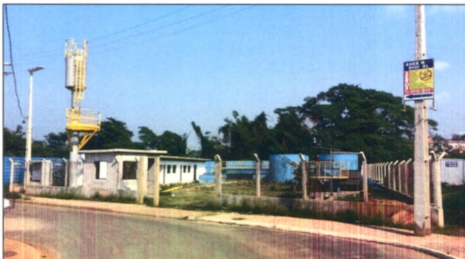
Imagem 01: ETE do Loteamento Vale do Sol (obra inacabada)
