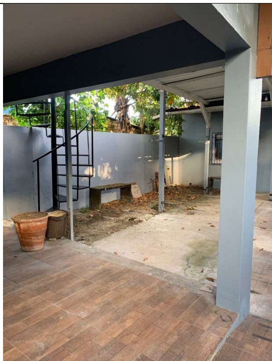
Item 11 – Area Externa 01
