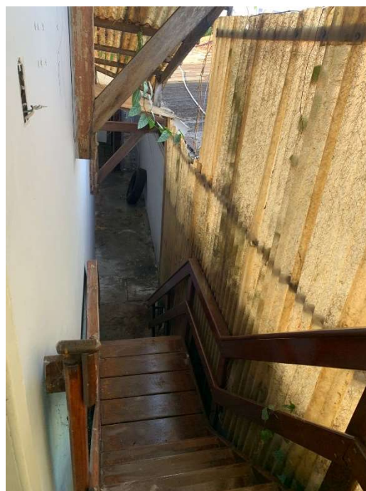
Item 16 – Escada externa 01
