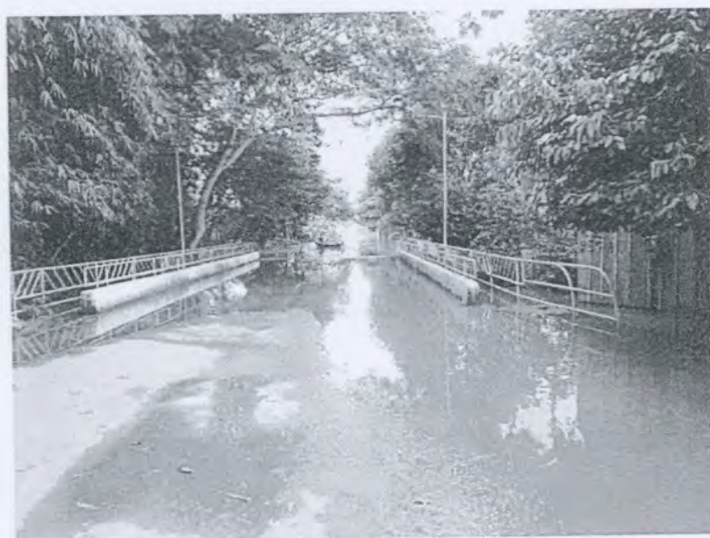
Ponte ru 11, Liberdade I - 10/02/2018
