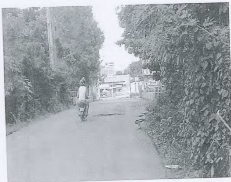
Ponte rua Sol poente, Bairro União - 10/02/2018
