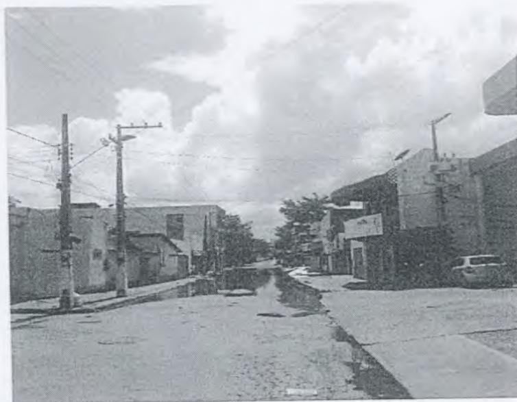
Rua "P", Bairro União - 10/02/2018
