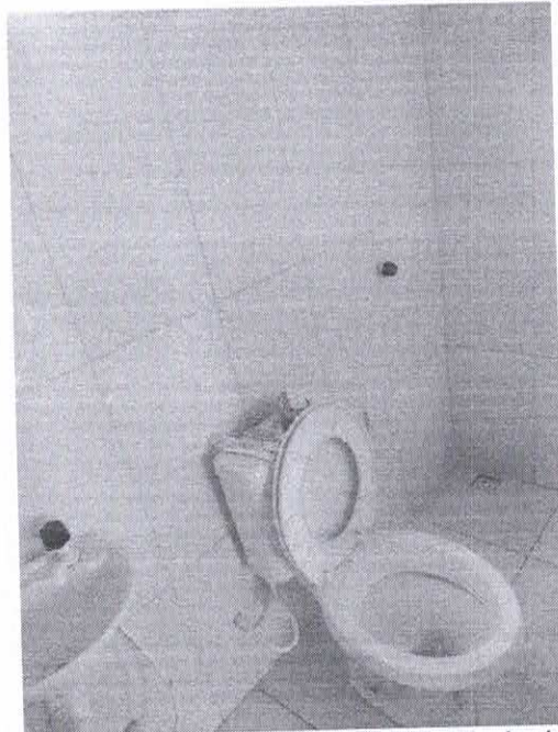
Imagem 5 - Vista do banheiro do imóvel
