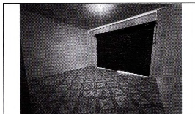
Foto 06: Ambiente para sala de aula
