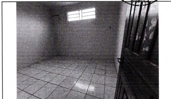
Foto 02: Ambiente para sala de aula
