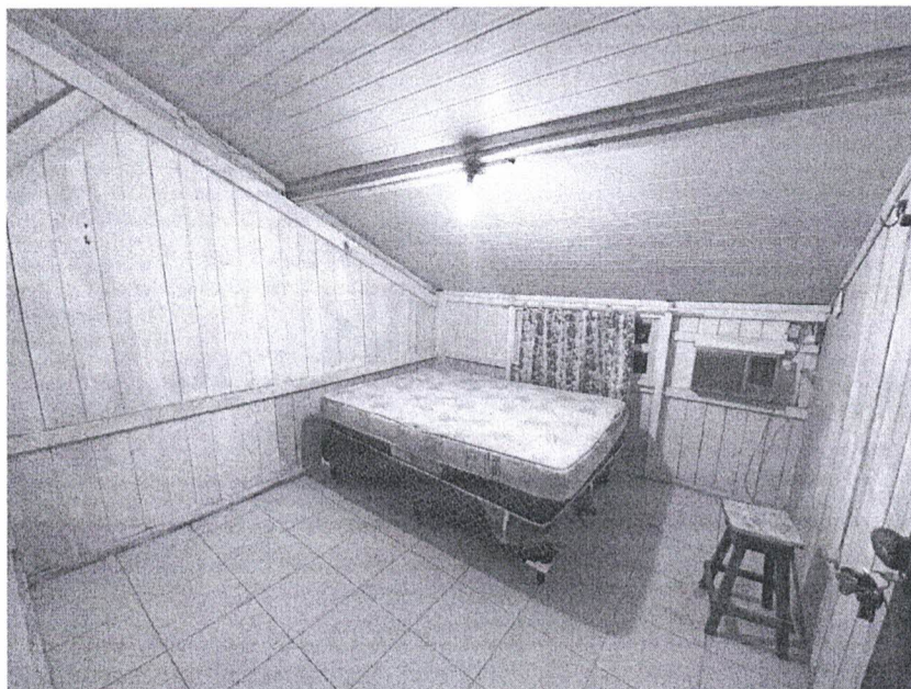
FOTO 13: QUARTO 03 - PISO CERÂMICO / FORRO PVC.
