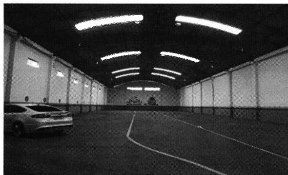
Foto 02 Área interna do galpão.
