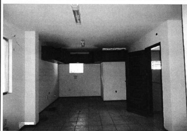
Foto 14 Armários de madeira instalado para atender o administrativo.
