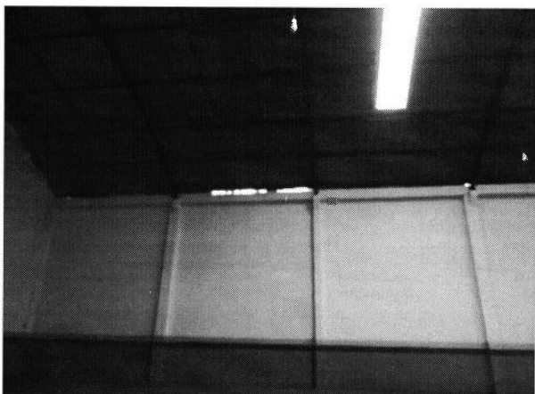
Foto 05 Paredes rebocadas e pintadas.
