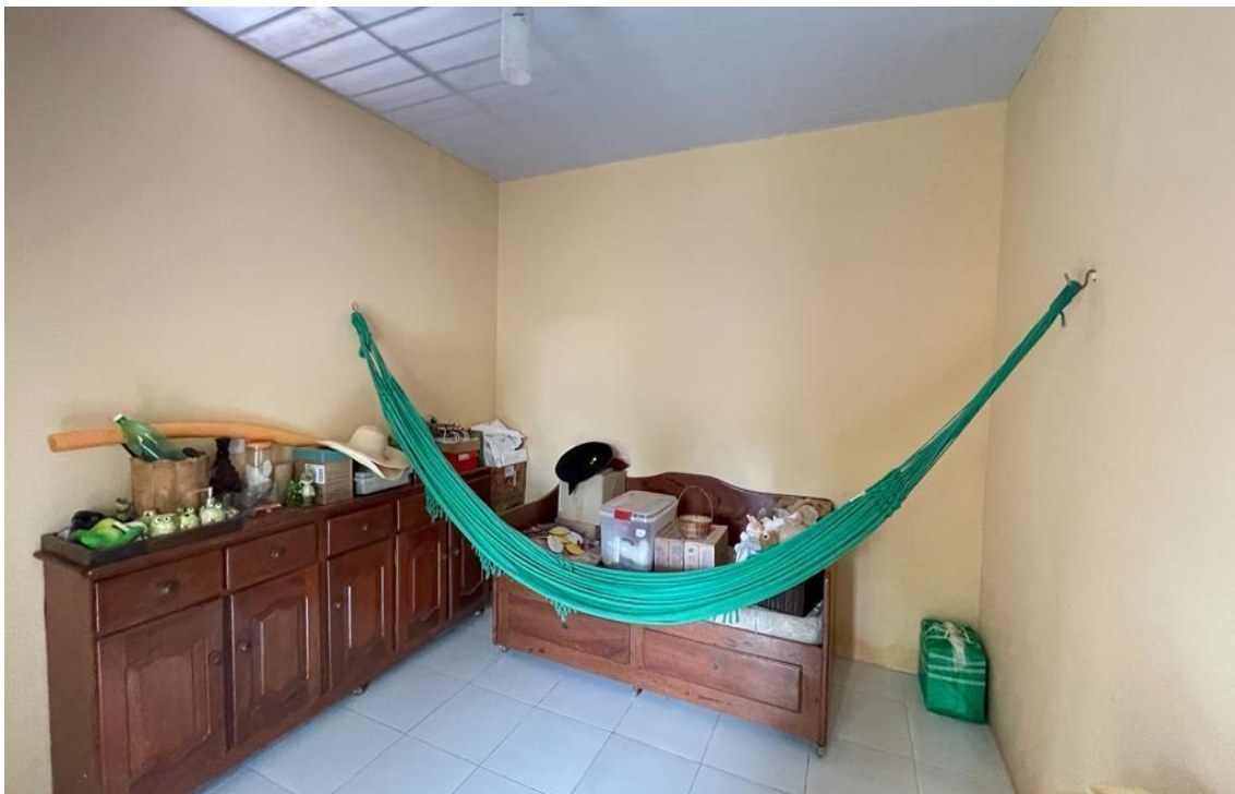
Figura 5 – Quarto: com forro em lambril de pvc, paredes argamassadas e com pintura, piso em lajota cerâmica, portas de 02 (duas) folhas de madeira.
