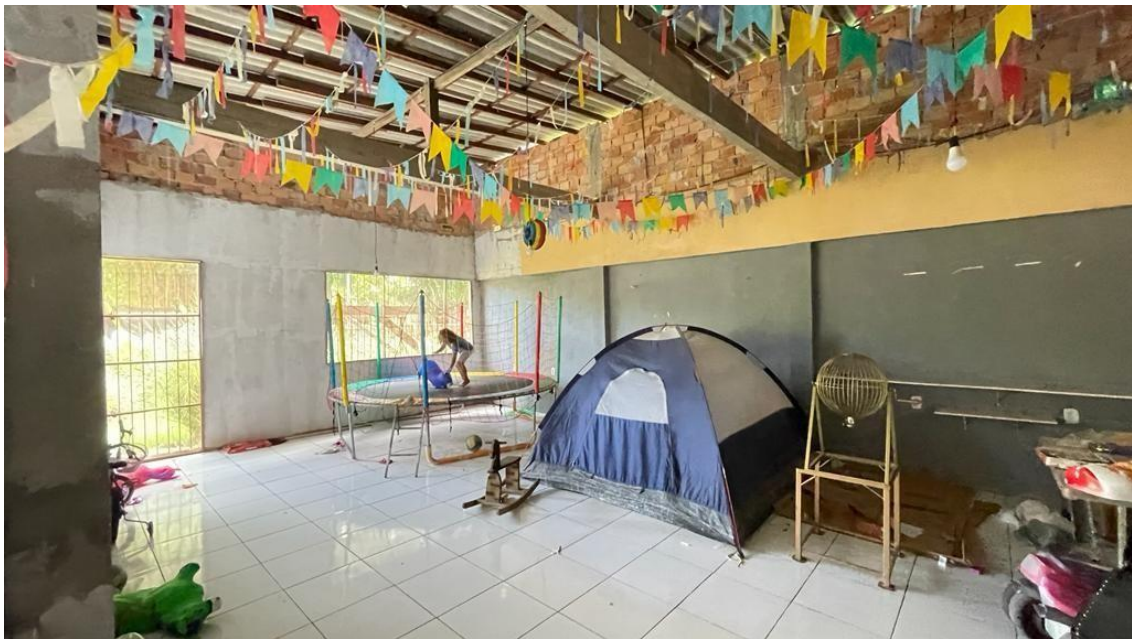
Figura 15 – Salão: paredes argamassadas e com pintura, piso em lajota cerâmica, grades de ferro, portão de ferro, ausência de forro.
