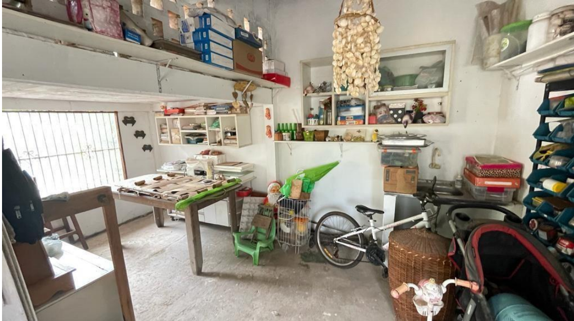
Figura 21 – Sala: paredes com pintura, piso cimentado, portas de madeira, janela com gradil, cabeamento elétrico irregular.
