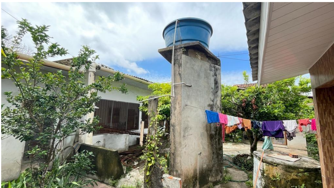
Figura 22 – Torre para caixa d'água em concreto, reservatório de água em fibra.
