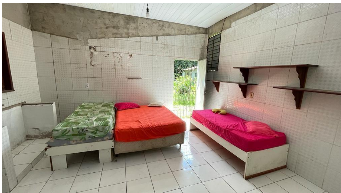
Figura 20 – Quarto: com forro em lambril de pvc, paredes com revestimento cerâmico, piso em lajota cerâmica, portas de 02 (duas)
