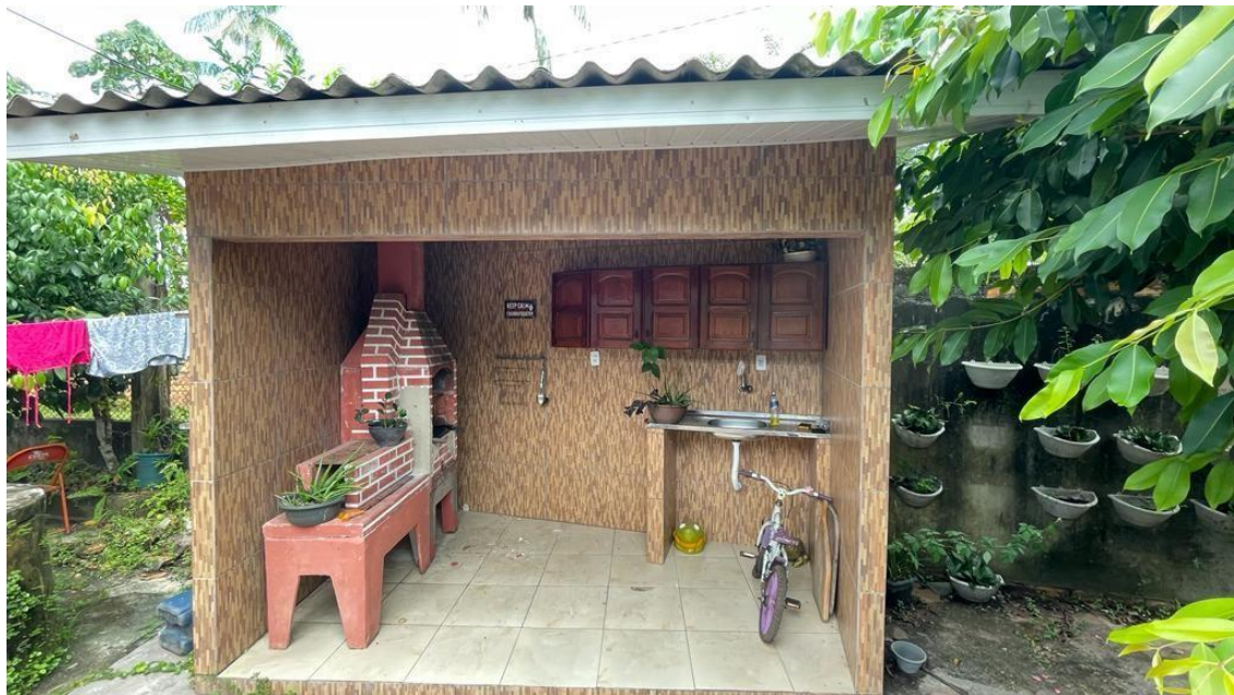
Figura 23 – Área gourmet, cobertura com telhas de fibrocimento, forro em lambril de pvc, paredes com revestimento cerâmico, piso lajota cerâmica.
