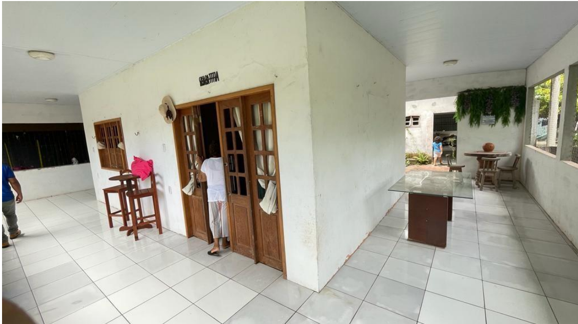
Figura 4 – Corredor de circulação: forro em lambril de pvc, paredes argamassadas e com pintura, piso em lajota cerâmica, grades em trama metálica, portão de ferro.
