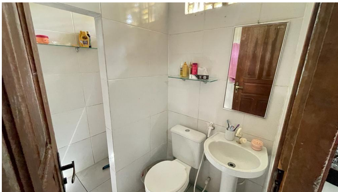
Figura 19 – Suítes: com forro em lambril de pvc, paredes argamassadas e com pintura, presença de morfo, piso em lajota cerâmica, banheiro com forro em lambril de pvc, paredes com revestimento cerâmico, portas em madeira, louças sanitárias adequadas para uso adulto, instalações elétricas irregulares.
