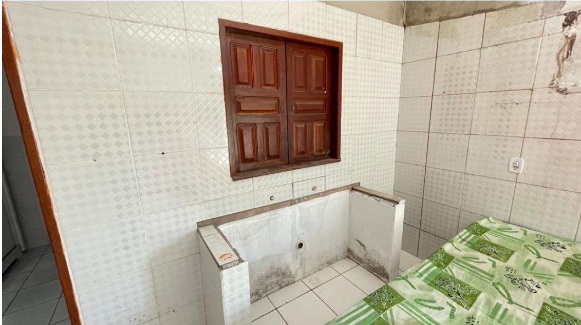
Demolição de membro em alvenaria com revestimento cerâmico.
