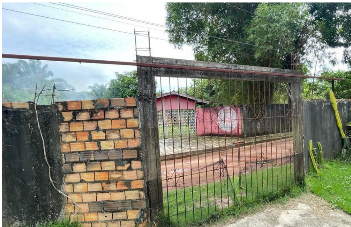
Demolição de estrutura de concreto
