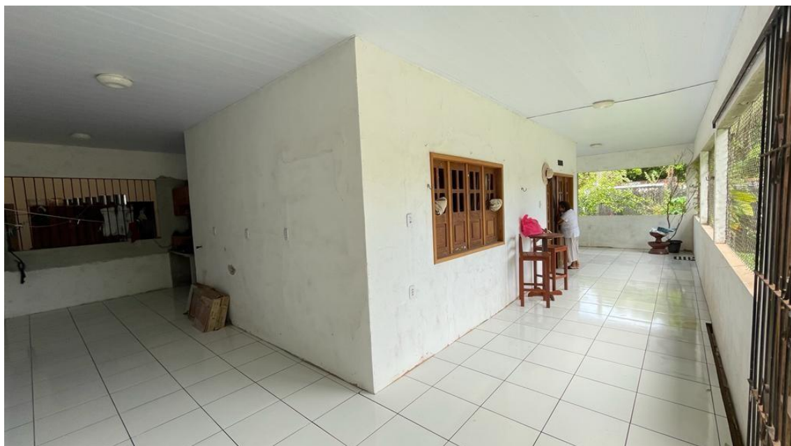
Figura 3 – Hall de entrada: forro em lambril de pvc, paredes argamassadas e com pintura, piso em lajota cerâmica, grades em trama metálica, portão de ferro.
