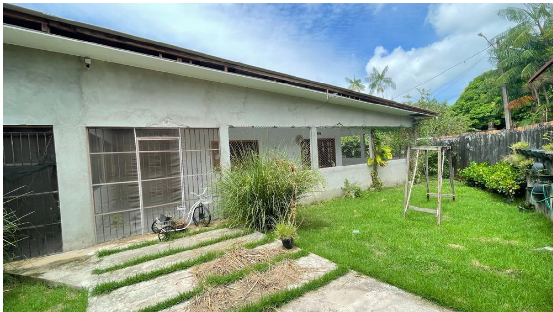
Figura 2 – Entrada do imóvel: grama e piso cimentado.
