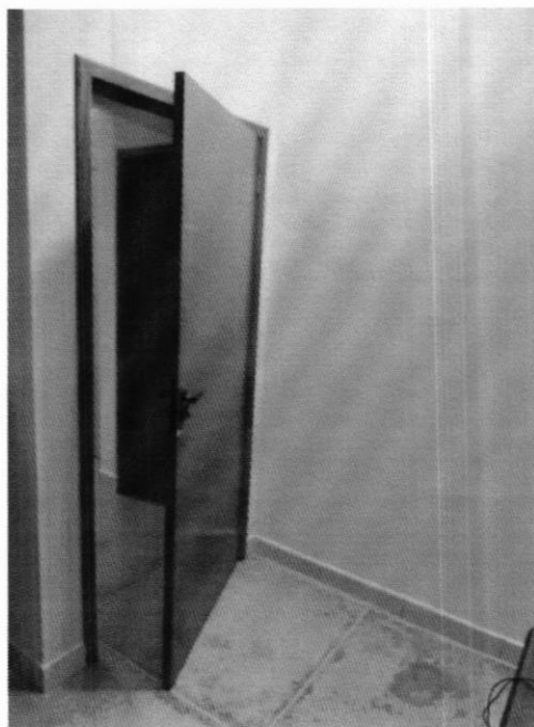
Figura 8 – Algumas portas em bom estado de conservação.
