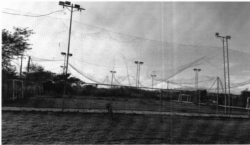
Figura 11 – Quadra de esporte completamente sem uso por estar deteriorado.
