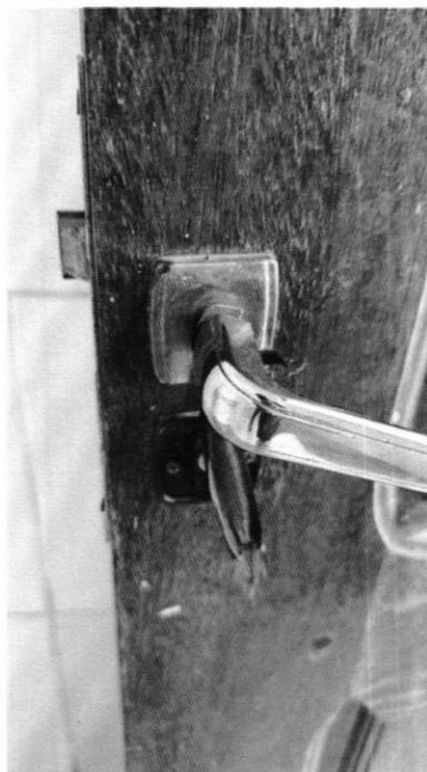
Figura 7 – Fechaduras quebradas.
