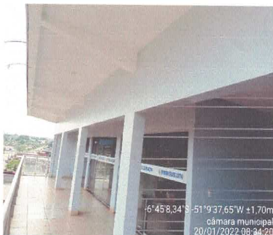
Figura 8: Pavimento Superior, entrada para as salas.
