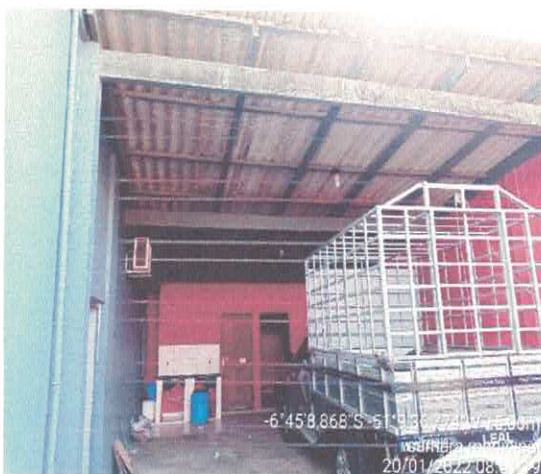
Figura 10: Cobertura externa para Estacionamento.
