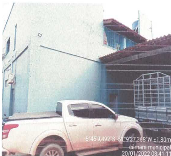
Figura 6: Fachada Posterior da Edificação.
