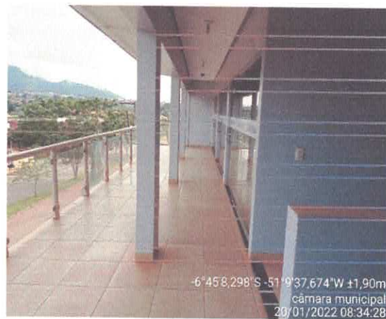
Figura 9: Varanda, pavimento Superior da edificação.
