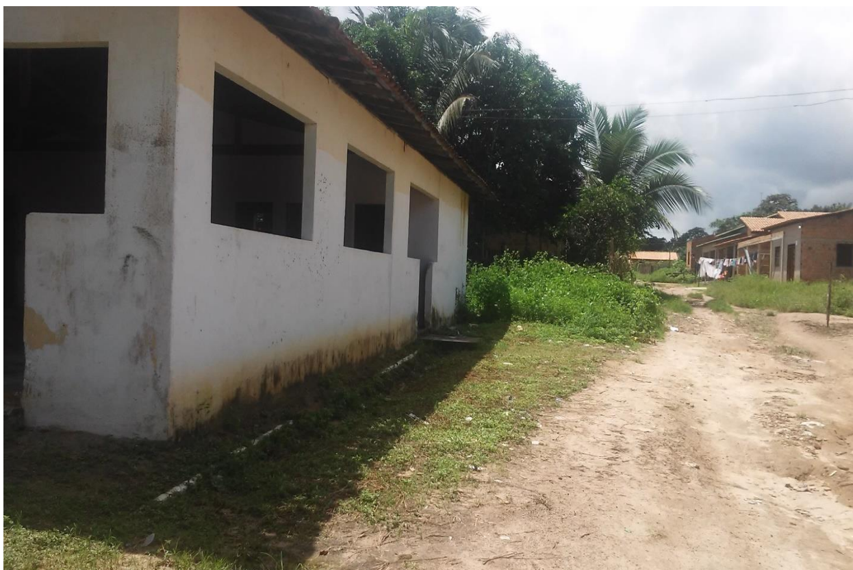
Reg. fotográfico da situação-Engenharia e Fiscalização/SEMUSB/PMB
