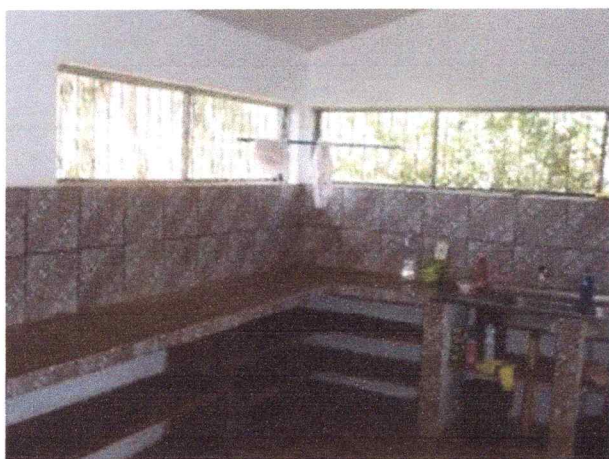
Foto 03: vista da cozinha
