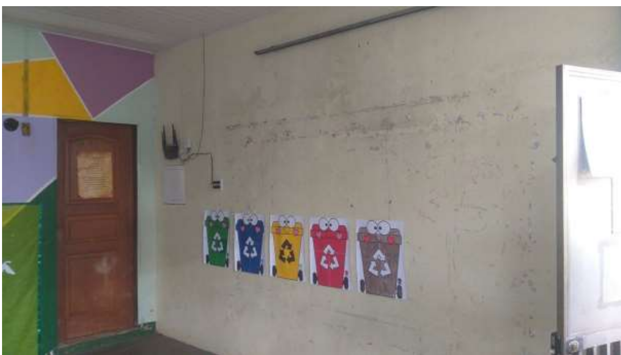
FOTO 04 – PINTURA DE SALA DE AULA
