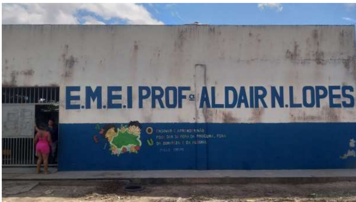
FOTO 01 – PINTURA DA FACHADA DA ESCOLA
