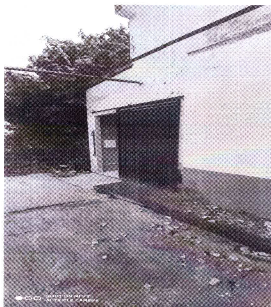
ENTRADA PARA OS BANHEIROS
