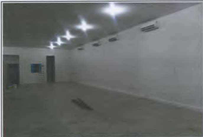
Foto 01: Vista geral interna do galpão
