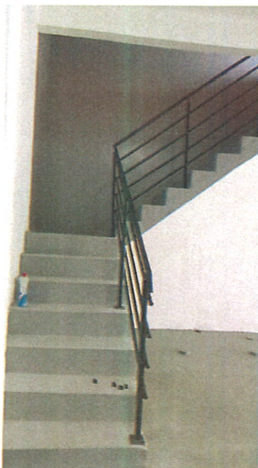
Hall da escada pav. térreo
