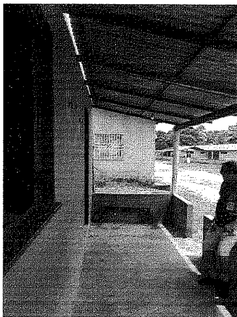
Imagem 3 - Vista do pátio da edificação, evidenciando acabamento de piso e cobertura
