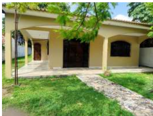
Vista área externa, fachada principal.
