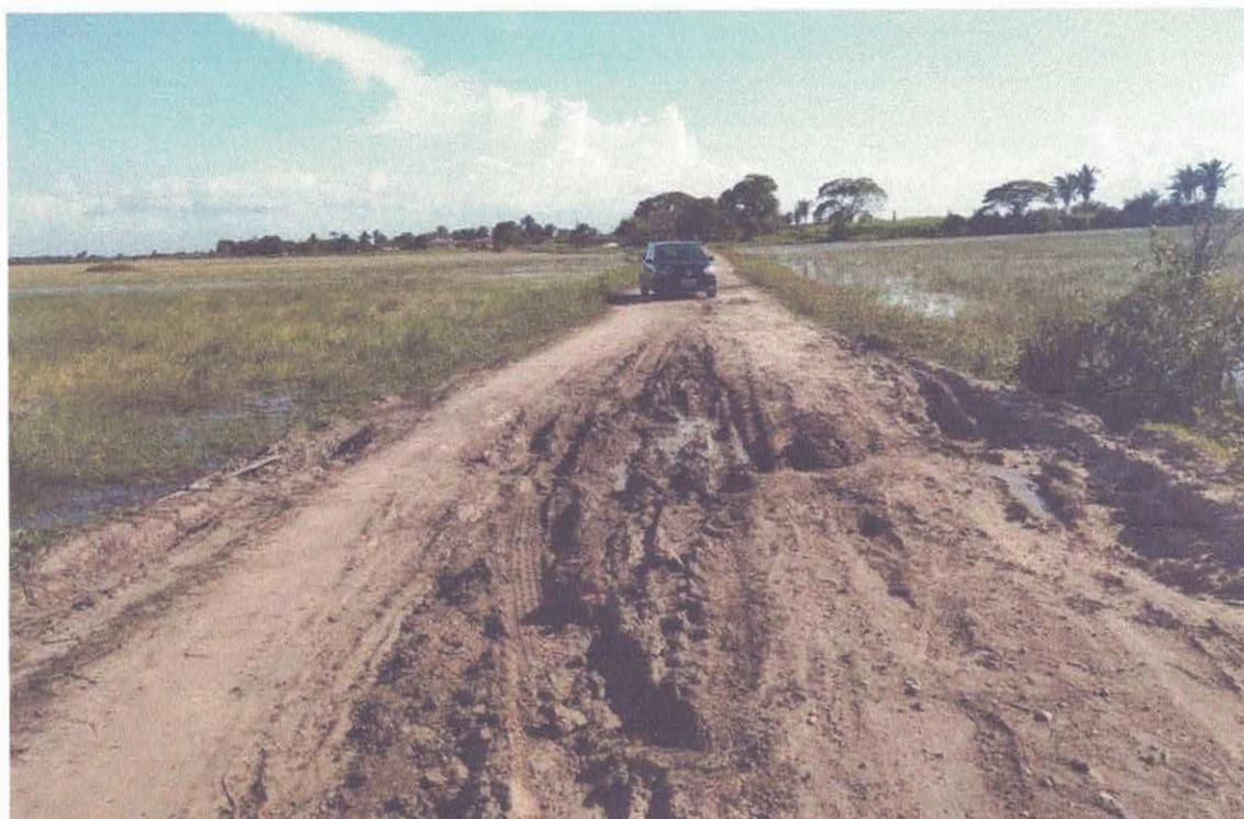
FOTO 05: Estrada na comunidade da Ilha Serrada. Aterro com trecho interditado
