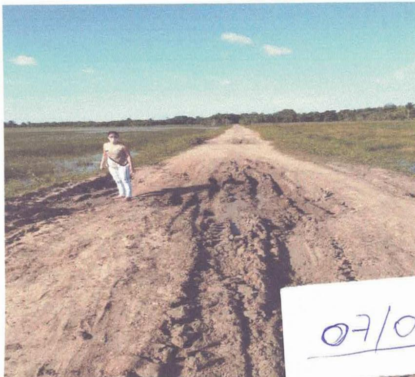
FOTO 07: Estrada na comunidade da Ilha Serrada. Marcas de tráfego, no trecho comprometido.
