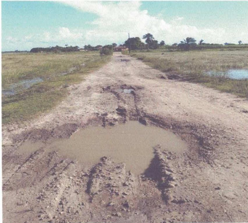
FOTO 06: Estrada na comunidade da Ilha Serrada. Aterro com trecho danificado.
