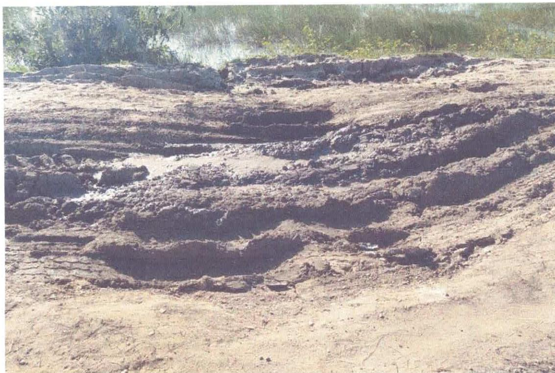
FOTO 03: Estrada na comunidade da Ilha Serrada. Marcas do tráfego em trecho comprometido.
