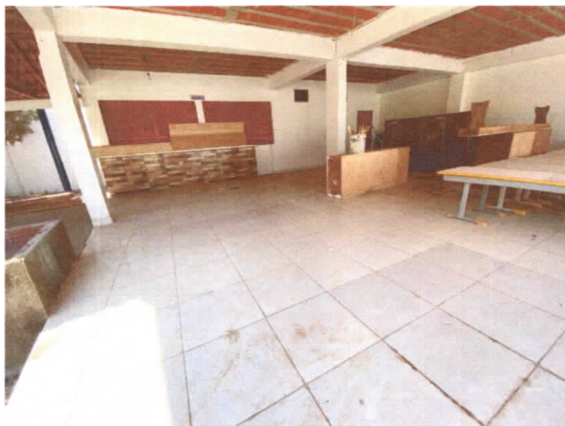
Figura 3 – Vista da cozinha/cantina
