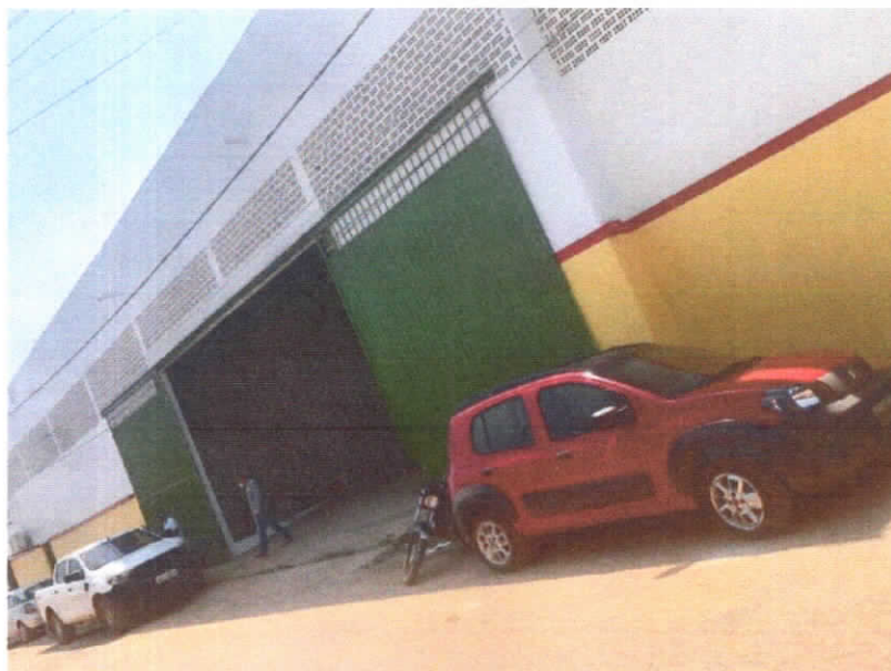
Figura 7 – Portão de acesso à garagem
