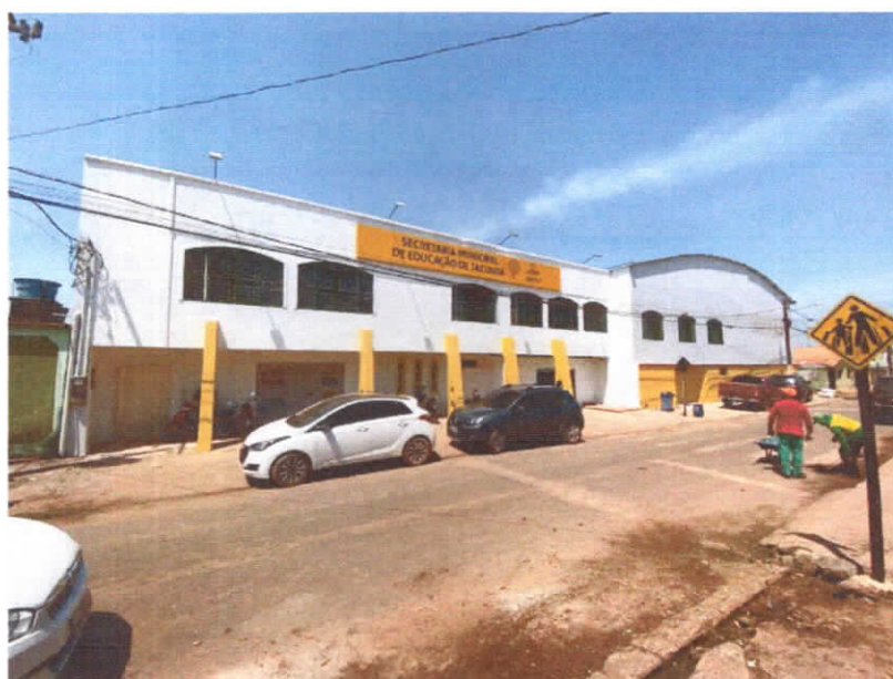
Figura 1 – Vista frontal da edificação
