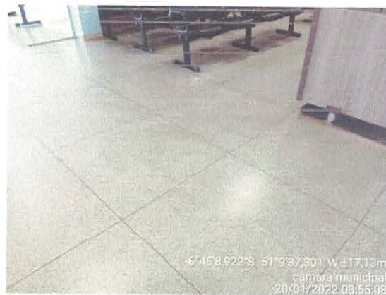
Figura 9: Piso em granitina no Pavimento Térreo.
