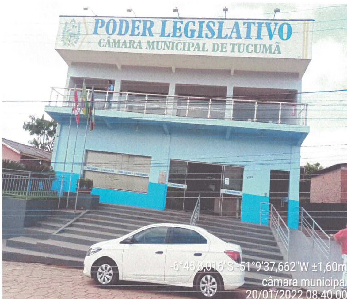
Figura 1: Fachada Principal da Edificação
