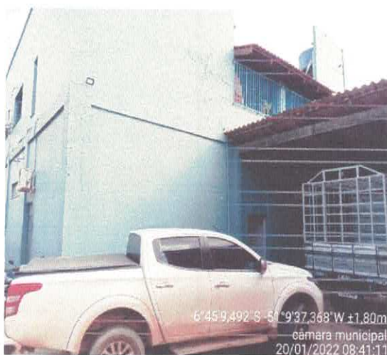
Figura 6: Fachada Posterior da Edificação.
