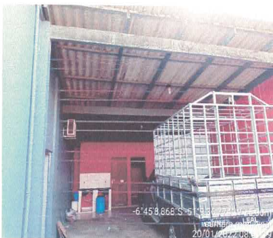
Figura 10: Cobertura externa para Estacionamento.
