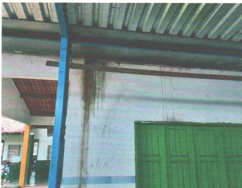
Figura 3-7 – Calha do refeitório.
