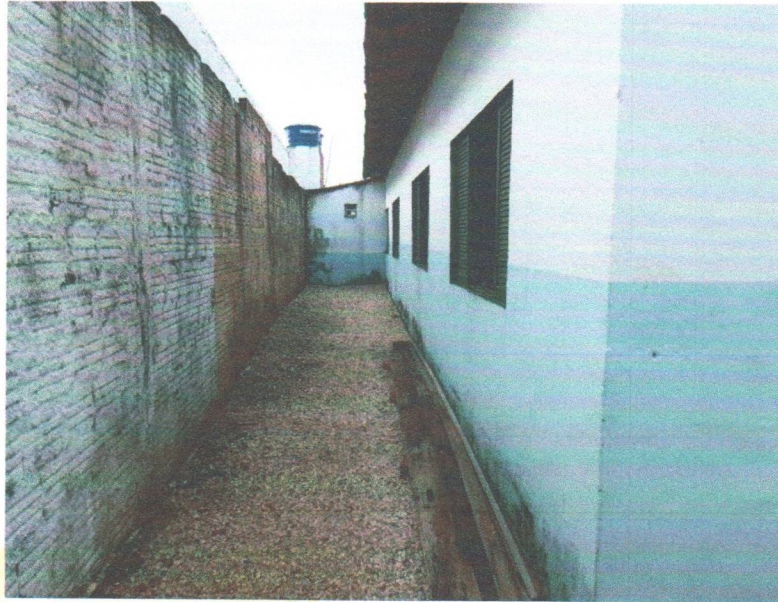
Figura 3-5 – Lateral das salas.
