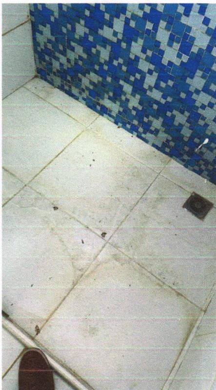
Figura 12 – Piso cerâmico com algumas partes encardidas.
