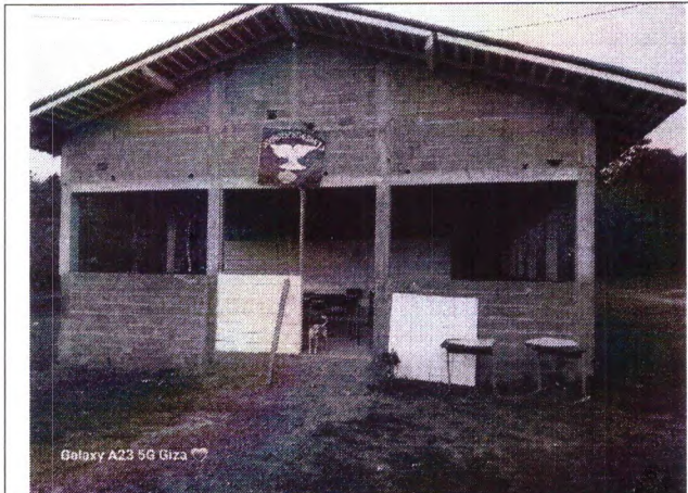
Vista Frontal (Fachada)
