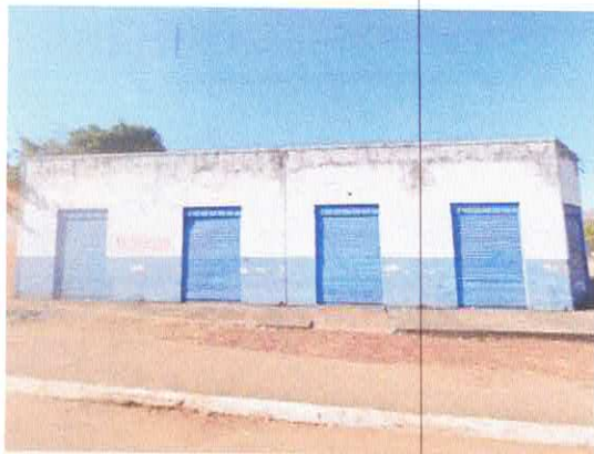
Imagem 01: Fachada do imóvel
