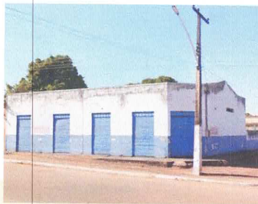
Imagem 02: fachada do Imóvel
