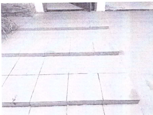
Figura 6: Revestimento da Escada Descolando
