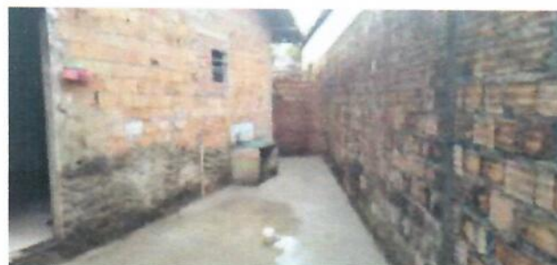
VISTA DOS FUNDOS - ÁREA DE SERVIÇO
