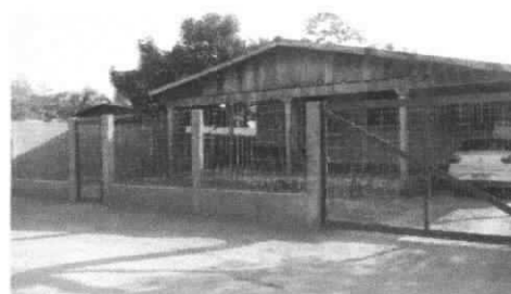
Figura 2 – Vista do Logradouro
