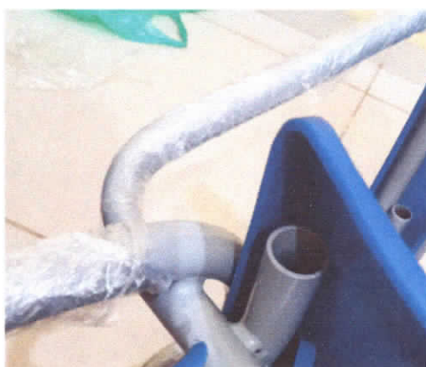
05.9 Pontas dos tubos cobertas por buchas plásticas em PP
