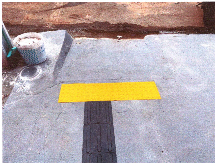
Foto 06 – Calçada de acesso
