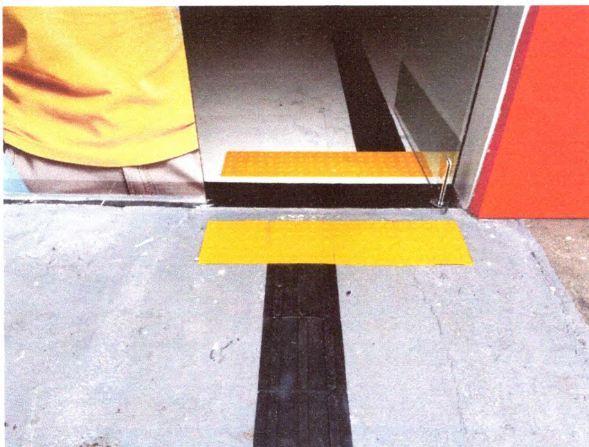
Foto 07 – Calçada de acesso
