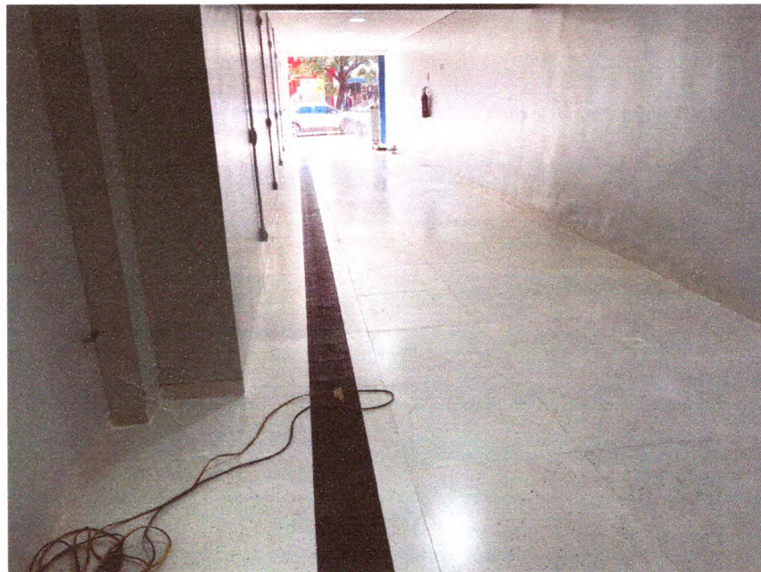
Foto 02 – Hall de entrada
