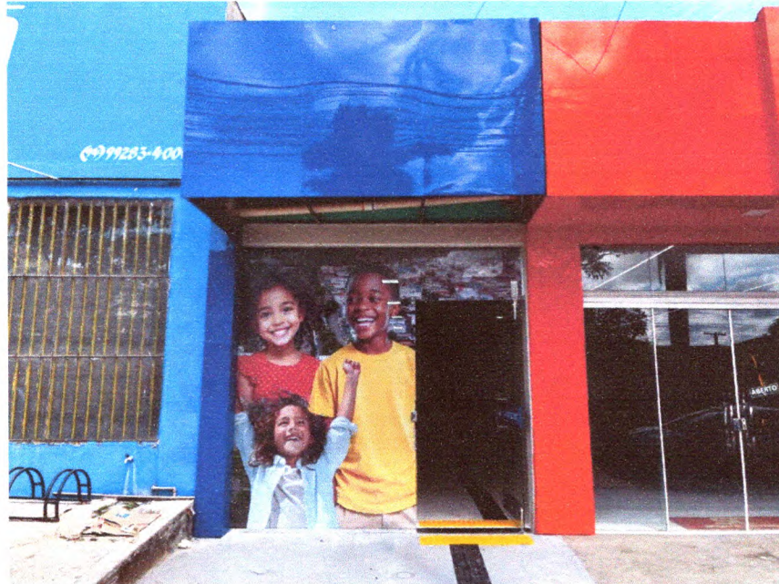
Foto 01 – Fachada do prédio
