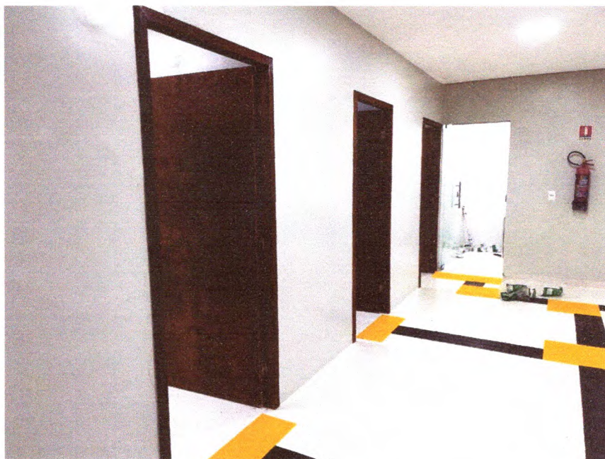
Foto 12 – Salão de acesso às salas
