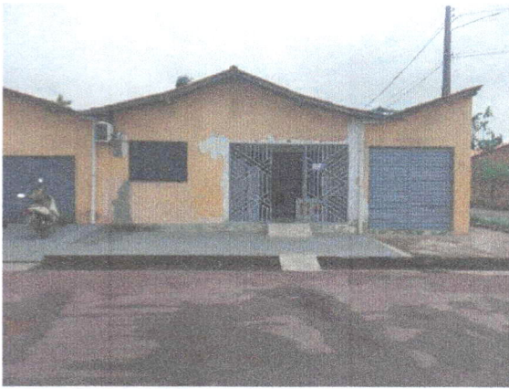
FOTO 01 - Fachada principal do prédio.
