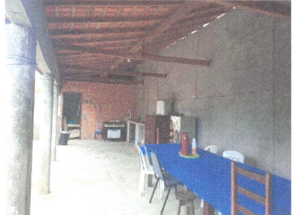
FOTO 08 – Refeitório e área de serviço.
