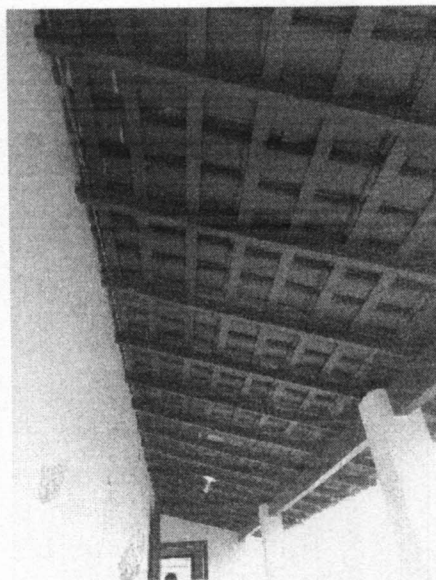
Imagem 08 – Telhado da varanda
