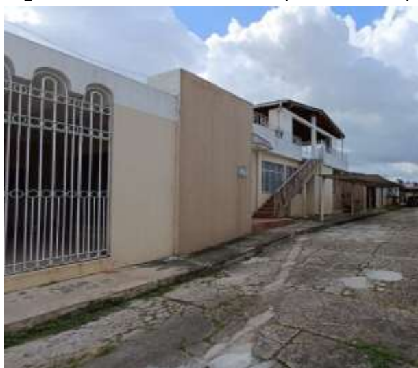
Imagem 3 – Lateral de acesso ao pavimento superior.
