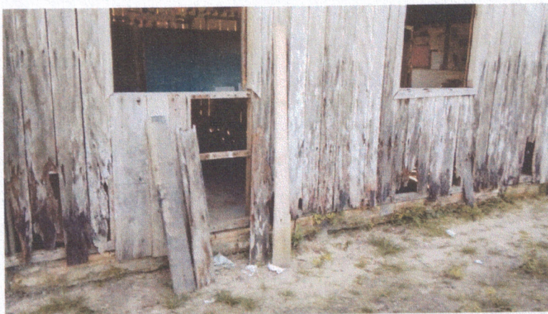
FOTOS 03: VISTAS EXTERNAS DA PAREDE DETERIORADA E DOS FUNDOS.
