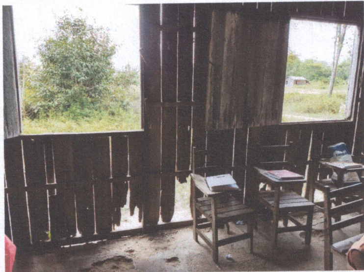
FOTOS 05: VISTAS INTERNAS DA SALA DE AULA, PISO E PAREDE DETERIORADOS.
