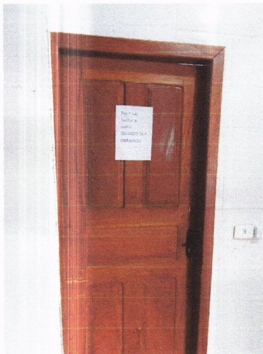
Figura 7 – Portas em bom estado de conservação.
