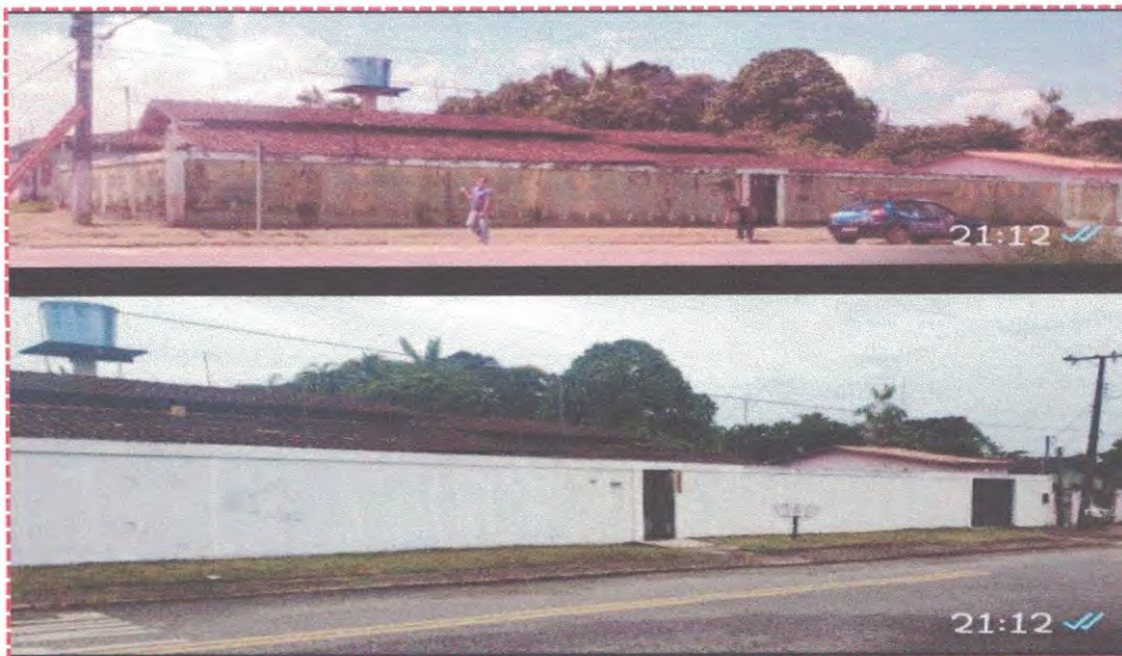
Foto 01: Fachada principal do imóvel
