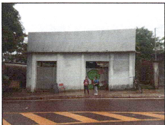
Foto 01: Vista da fachada principal do prédio.
