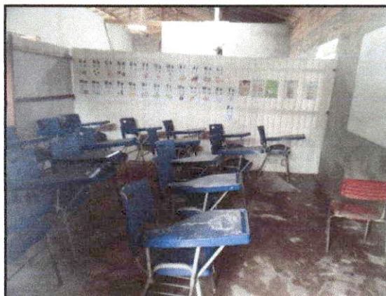
Foto 02: Interior da Sala 01.
