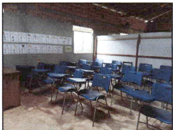
Foto 03: Interior da Sala 02.
