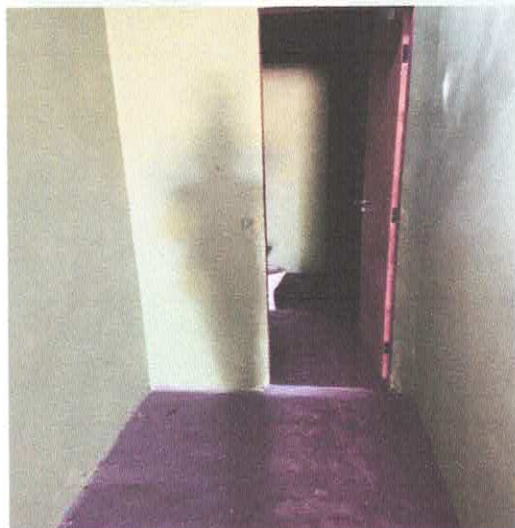
Imagem 05: entrada do Banheiro do imóvel
