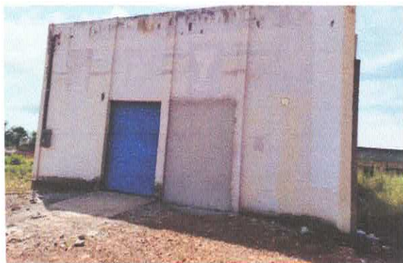
Imagem 01: Fachada do imóvel
