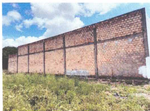
Imagem 02: Lateral do imóvel
