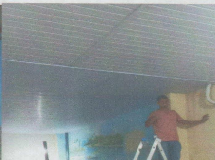
Forro- Prédio SEMED
