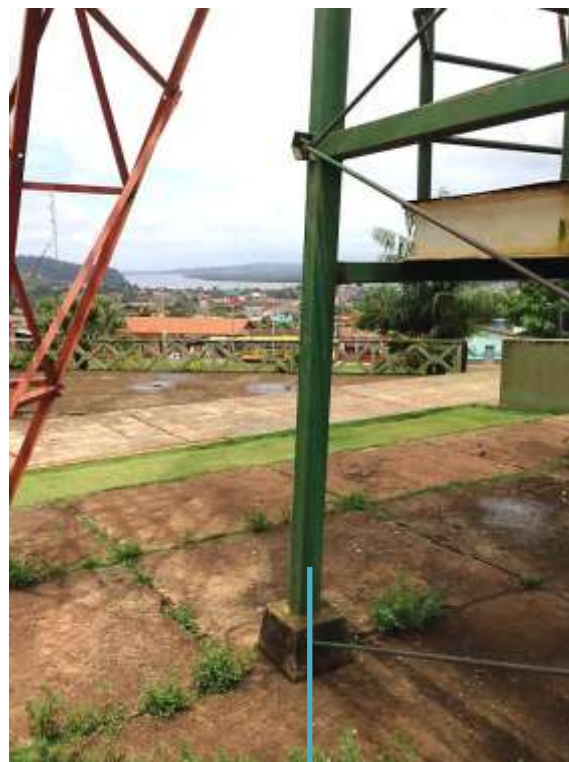
Estrutura de apoio da escada e observatório.
