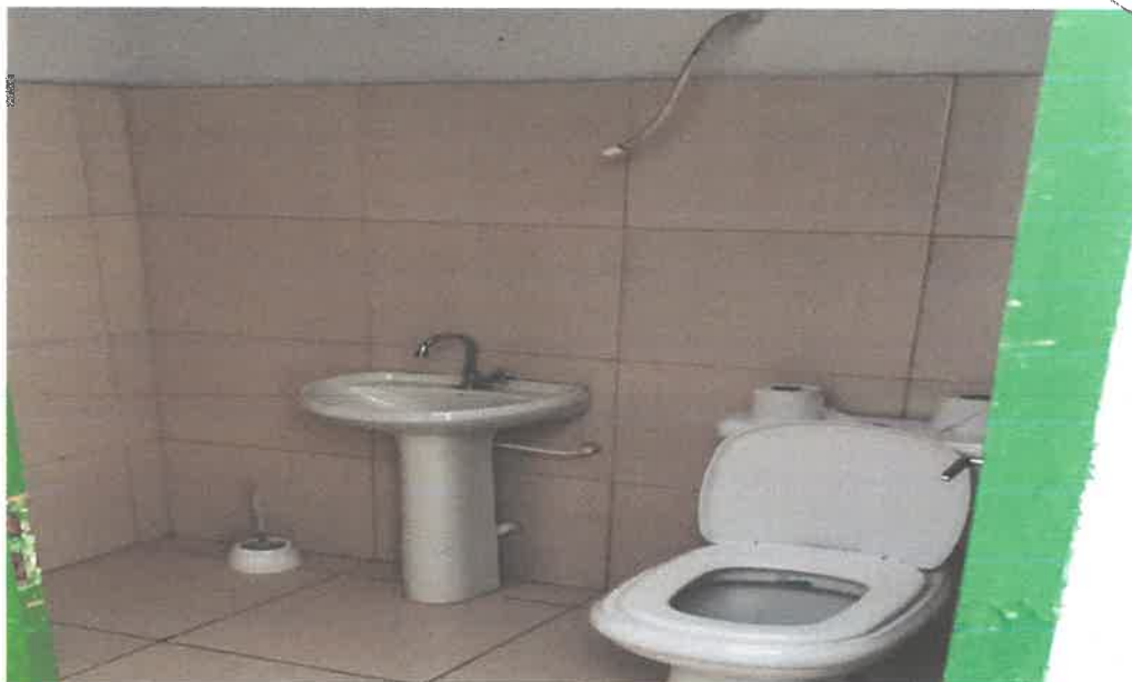
BANHEIRO 02 – AO PÚBLICO
