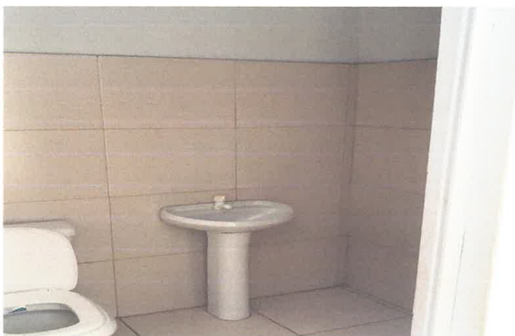
BANHEIRO 01 – AO PÚBLICO
