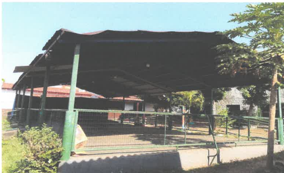
GALPÃO METÁLICO ABERTO
