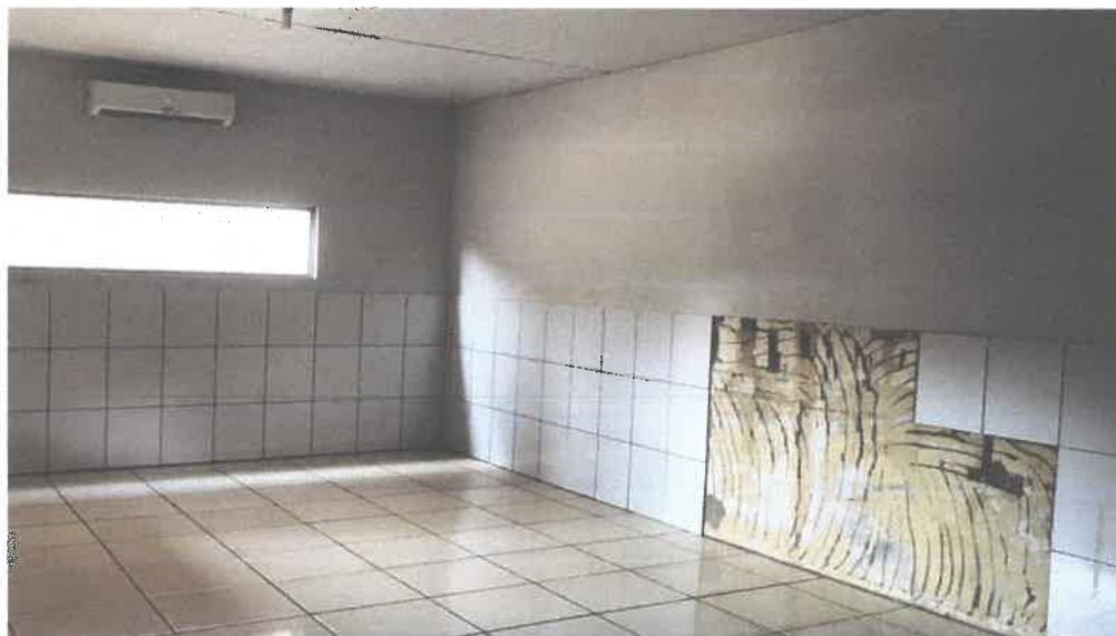
SALA DE TEATRO (AZULEIJOS QUEBRADOS) – INTERIOR
