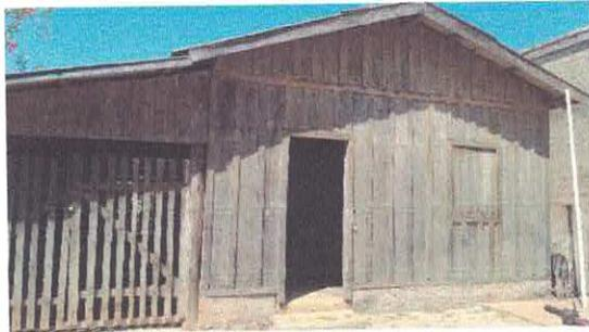
**Figura 1** – Imagem da fachada frontal do Imóvel. Edificação em madeira, coberta com telha cerâmica, pintada, caracteriza um padrão baixo de acabamento.
