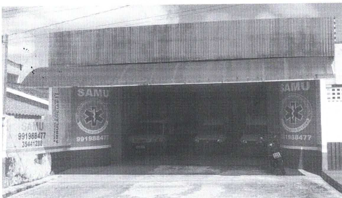
Figura 1 – Infraestrutura, estrutura e cobertura.
