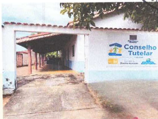
Imagem 02: Fachada do Imóvel
