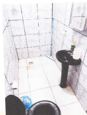
Imagem 06: Banheiro do Imóvel
