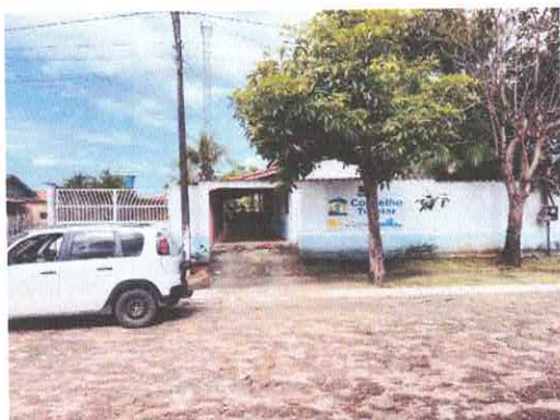
Imagem 01: Fachada do Imóvel
