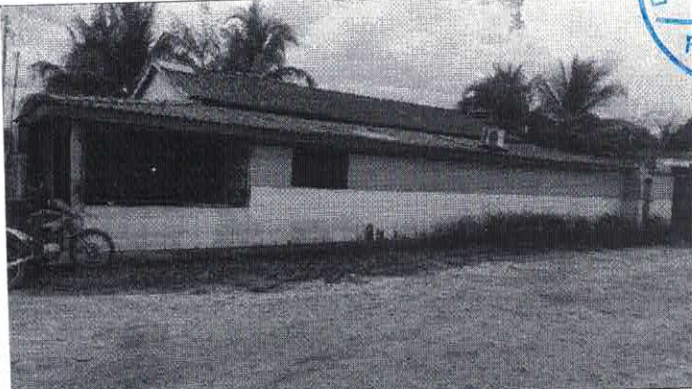
IMAGEM 02: Fachada da edificação. Imóvel possui aproximadamente 200,00m 2 de área construída, com ambientes bem distribuídos para a finalidade de escola infantil.
