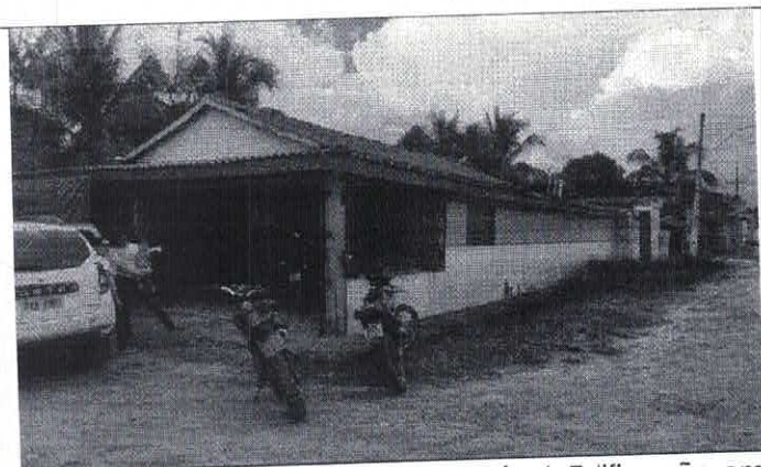
IMAGEM 01: Fachada frontal do imóvel. Edificação em alvenaria cerâmica, cobertura em telha cerâmica, rebocada e pintada, caracteriza um padrão médio de acabamento.
