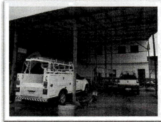
Foto 02: Estacionamento e prédio principal.
