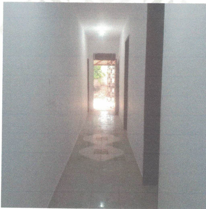
Figura 02- Térreo-Corredor da edificação
