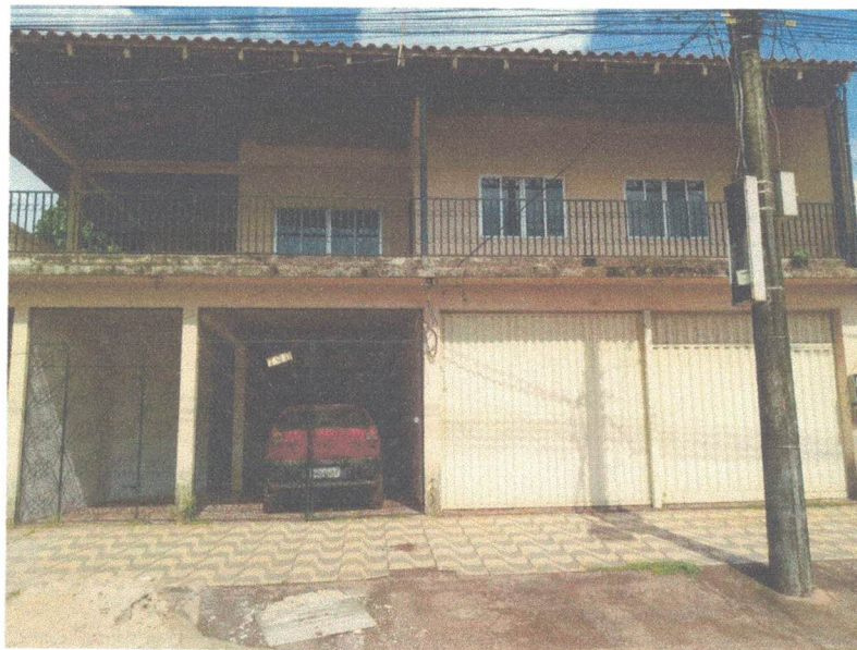
Figura 01- Fachada da Edificação
