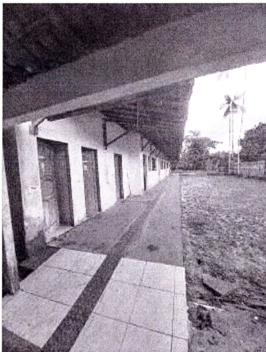
Figura 20 – Bloco de salas de aula e bho's
